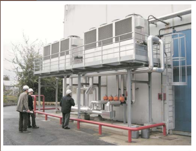
2 Centrales CEK de 140 kw chacune (Industrie plastique)
